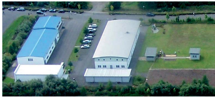
EBINGER Technikzentrum Wiesbaum
