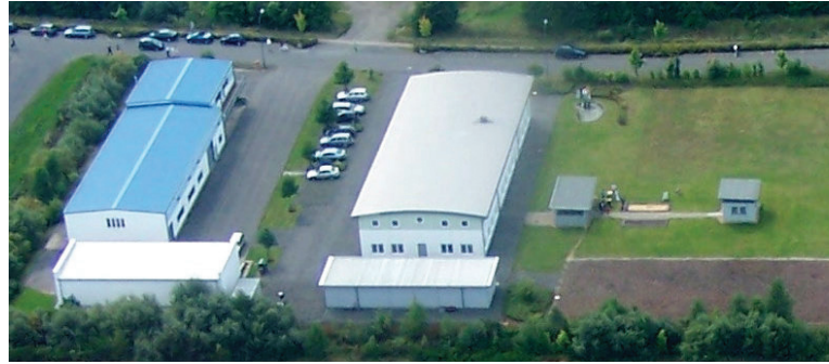
EBINGER Technikzentrum Wiesbaum
